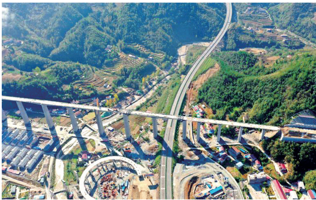
郑万高铁保康段将于2021年底建成通车。通车后，保康到襄阳只要18分钟，到武汉1个半小时。图为合龙后的郑万高铁天池大桥。 陈泉霖 / 摄
