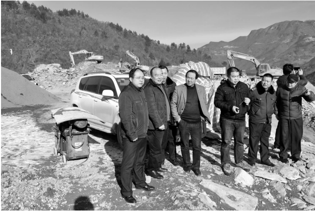
4月，县安全监管干部到高速公路建设工地对安全生产情况进行督查
