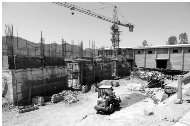
建设中的歇马骨干收纳库
