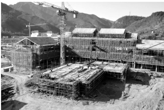
工商联招商引资的项目建设工地
