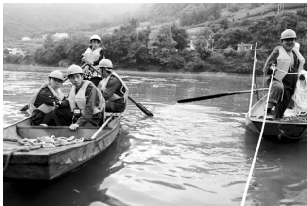
工人乘坐渡船进行电网拉线作业
