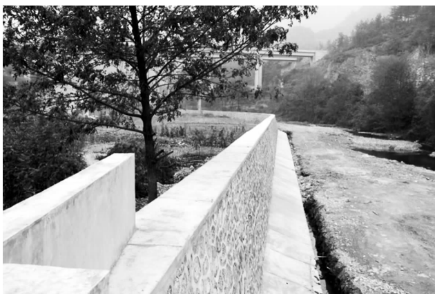
10月，黄堡河土门段山洪沟治理工程全面完工
