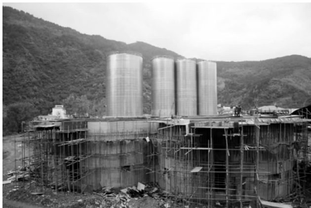
建设中的县荆楚水泥厂仓库
