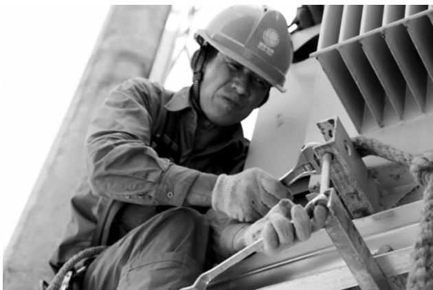
工人在进行配电网建设作业
