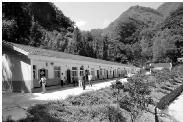
建成的凤凰山村弱势群体集中安置点
