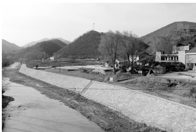
沮河歇马段中小河流治理工程
