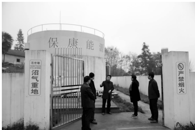
寺坪镇度家坪村“三”沼综合利用示范工程
