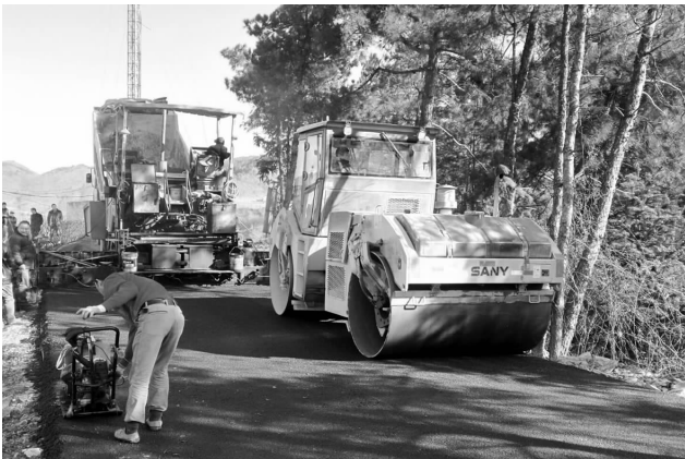
2016 年 12 月 27 日，官山旅游路一期工程油层铺筑
